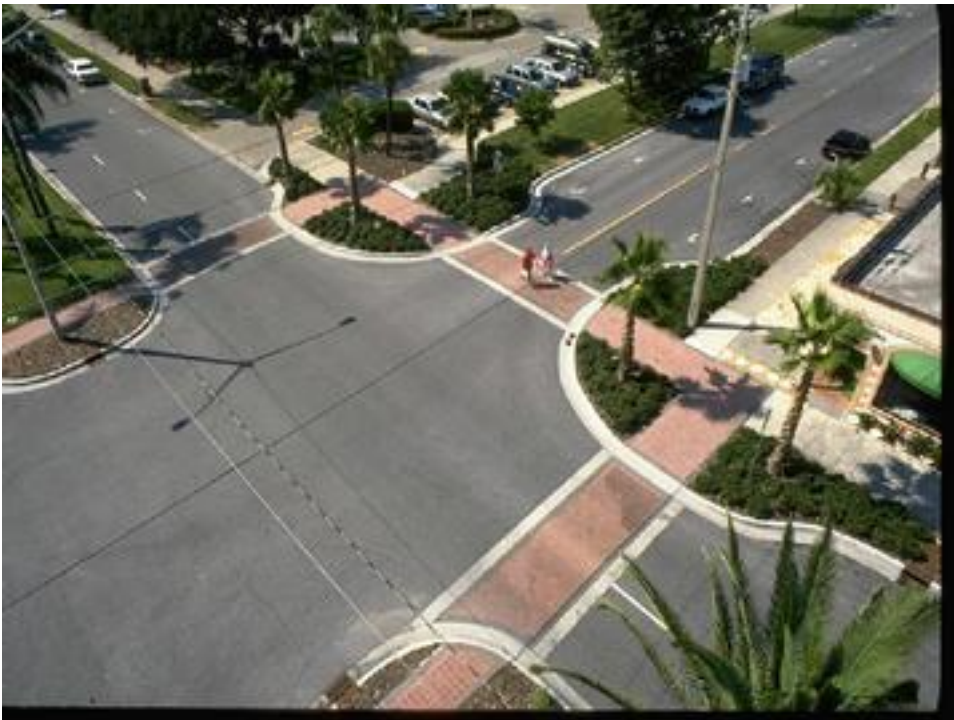
figura4: restringimento della carreggiata
